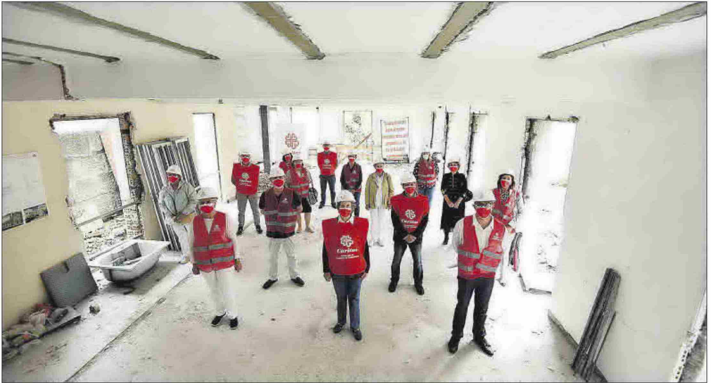
Voluntarios de Cáritas en el arranque de la obra del albergue, que ha completado ya su primera fase. // Gustavo Santos
